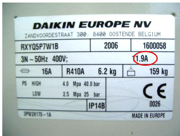
Рис.1 Величина тока МСА=11,9 А на шильде наружного блока системы VRF
