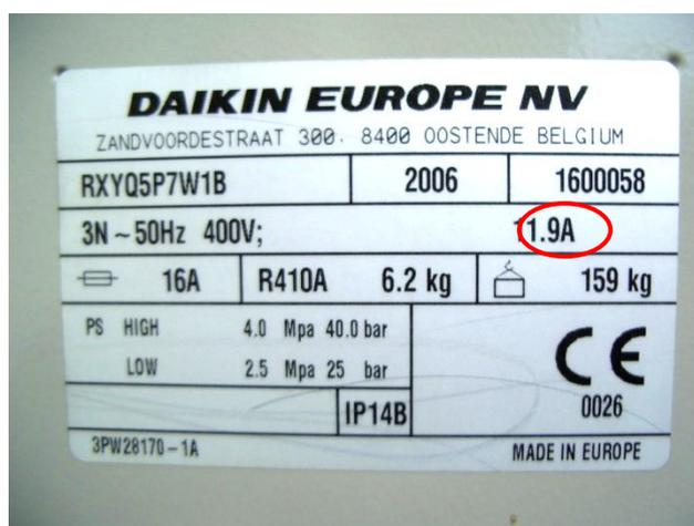
Рис.1 Величина тока  $MCA=11,9$  А на шильде наружного блока системы VRF
