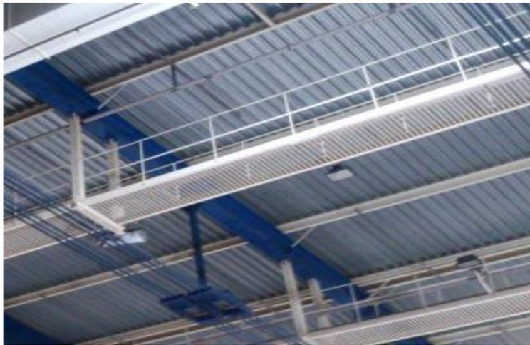
**Рис.5 Пример применения профилированного стального оцинкованного листа в качестве материала потолка в зале катка.**
