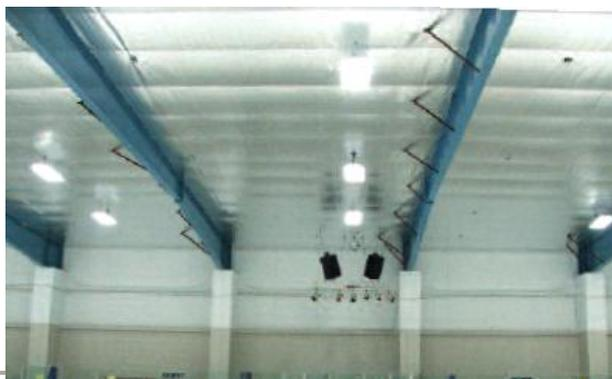
**Рис.3 Пример установки отражающего экрана под потолком катка.**
